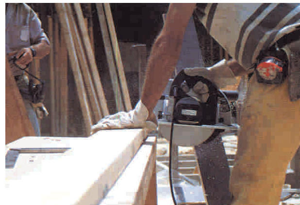
Figura 4 - 8: Protección de manos al efectuar cortes en la madera con sierra manual.
