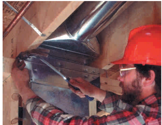
Figura 4 - 6: Trabajador usando las herramientas adecuadas, protección de los ojos y cabeza.
