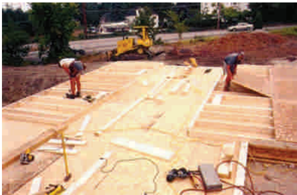
Figura 6 - 9: Construida la plataforma de piso, se inicia la construcción de los tabiques soportantes y autosoportantes.
