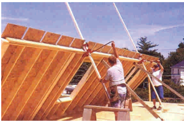
Figura 6 - 10: Una vez fabricados los tabiques sobre la plataforma, se procede a izarlos y ubicarlos en el lugar correspondiente.
