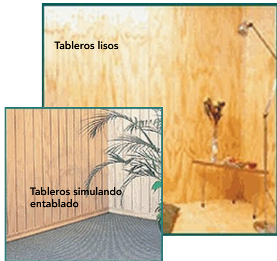
Figura 19 - 23: Revestimiento con tableros contrachapados.
