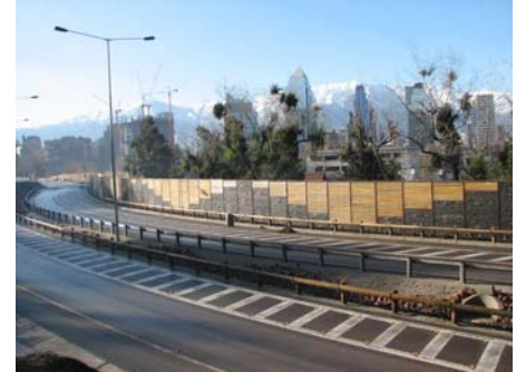
Acceso a túnel San Cristóbal, Providencia, Santiago
