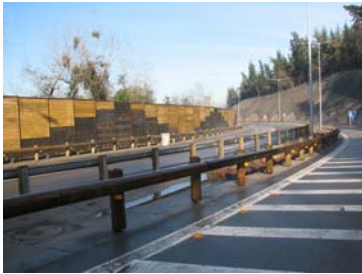
Barreras de contención y pantallas acústicas,
