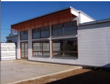
Sala Cuna construida en Villarrica, IX Región, año 2007
