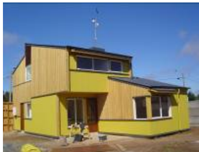
Vivienda construida en Temuco, año 2007
